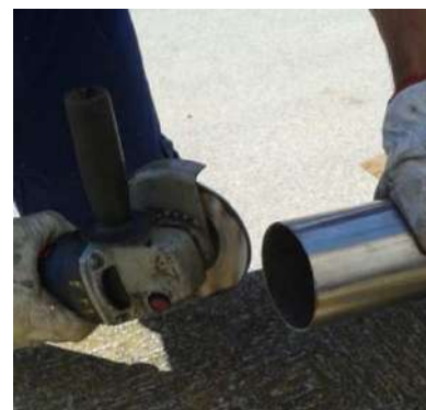
Meulage d'un tuyau
