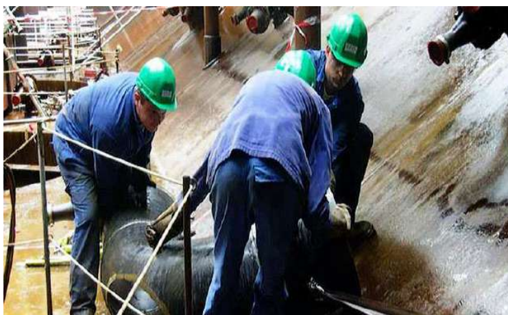
Manipulation d'un coude / tuyauterie de DN 400 par trois techniciens
