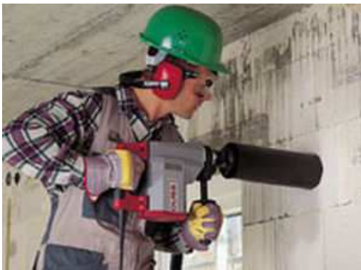
Traversées de parois au moyen de carotteuses
