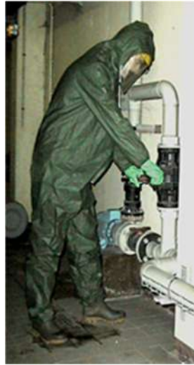
Maintenance sur pompes doseuses ou circuit de dosage
