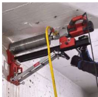
Installation puis utilisation d'une carotteuse sur bâti
