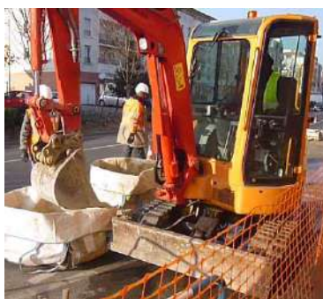
Mini-pelle sur chantier
