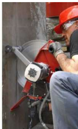
Installation puis utilisation d'une carotteuse sur bâti
