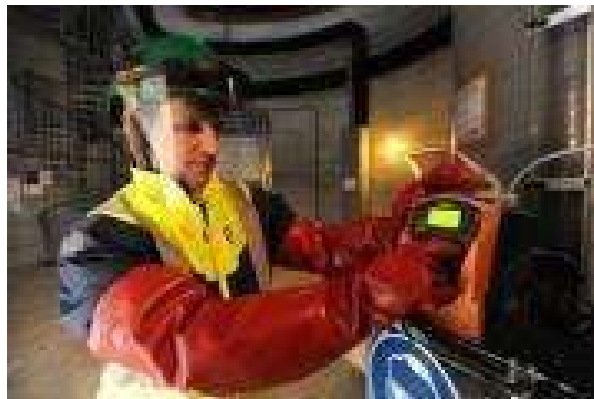
Intervention sur une pompe doseuse produit chimique
