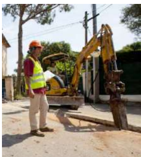
BRH monté sur mini-pelle
