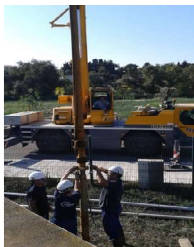
Opération de soudure sur un corps de pompe maintenu en suspension au-dessus d'un bassin biologique
