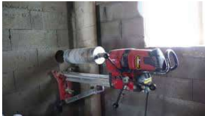
Traversées de parois au moyen de carotteuses
