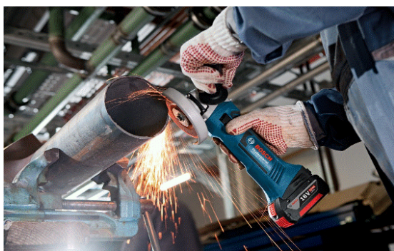
Chanfreinage d'une tuyauterie en atelier
