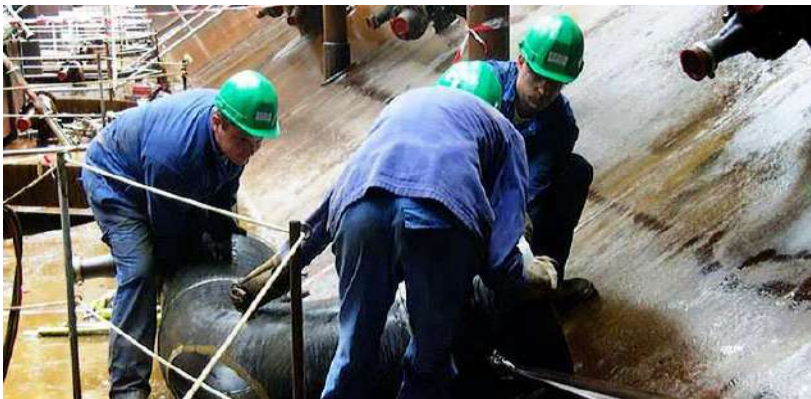
Déplacement d'une tuyauterie volumineuse par trois personnes en position "torses fléchis"
