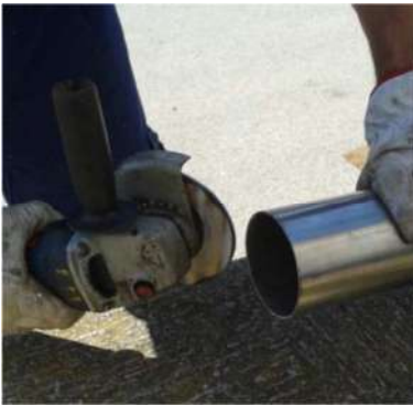
Meulage d'un tuyau
