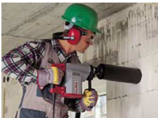
Carottage sur un mur béton (traversée de paroi)
