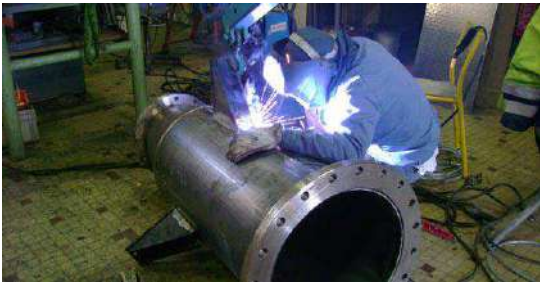
Soudure sur une canalisation en atelier et en position accroupie
