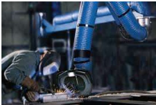
Soudure en atelier avec aspiration des fumées
