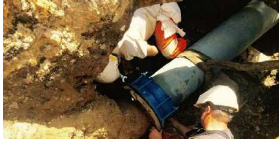
Raccordement d'une canalisation dans une tranchée par deux agents de maintenance à genoux (intervention en espace exigu)
